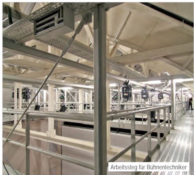
Großer Saal mit abtrennbaren Seitenbühnen und Arbeitsstegen im Dachraum
