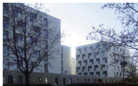
Studentenwohnheim (Architekt: Architekturbüro Karl + Probst, München; Bauherrengemeinschaft Studierendenwohnheime Campus Westend, Ffm)
