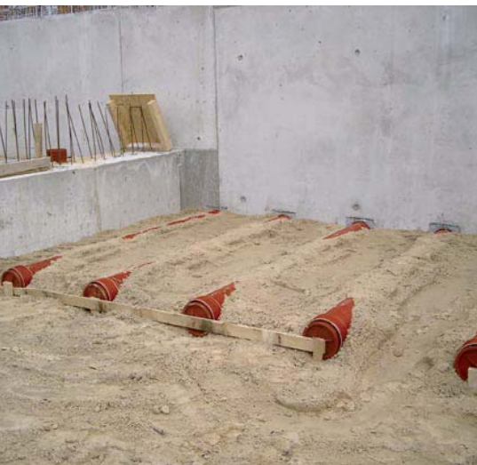
Verlegung der Erdwärmetauscherrohre Uni Potsdam
