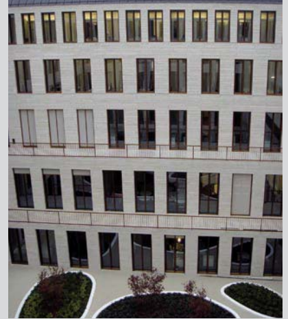
L-Bank (Architekt: Weinmiller Architekten, Berlin; Bauherr: L-Bank Baden-Württemberg – Förderbank, Karlsruhe)
