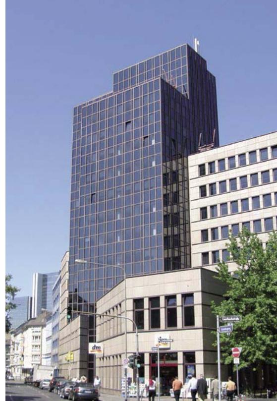
Grüneburgweg (Architekturbüro Tektonik Architekten, Frankfurt a.M.; Bauherr: MSREF Planet Frankfurt Eins GmbH, Frankfurt a.M.)
