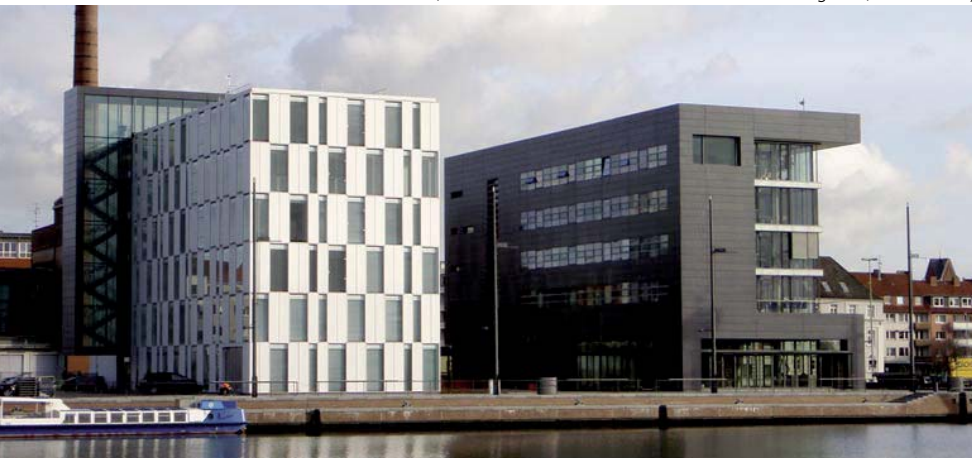
Neubau t.i.m.e.-Port III, Bremerhaven (Architekt: bof Architekten, Hamburg; Bauherr: BIS, Bremerhavener Gesellschaft für Investitionsförderung mbH, Bremerhaven)
