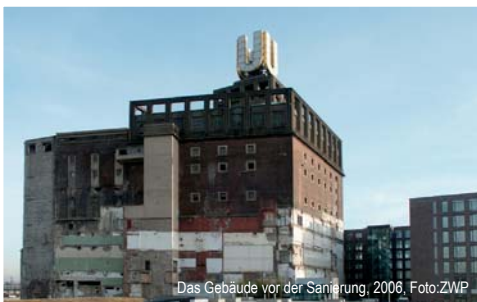
Das Gebäude vor der Sanierung, 2008. Foto: ZWP
