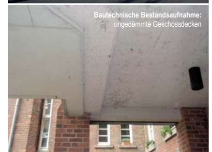
Bautechnische Bestandsaufnahme: ungedämmte Geschossdecken
