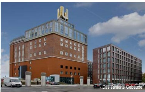
Das sanierte Gebäude
