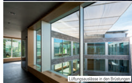
das neue Laborgebäude
