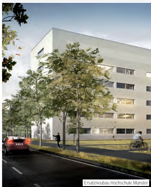
Ersatzneubau Hochschule Münster
