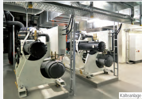
Kälteanlage
