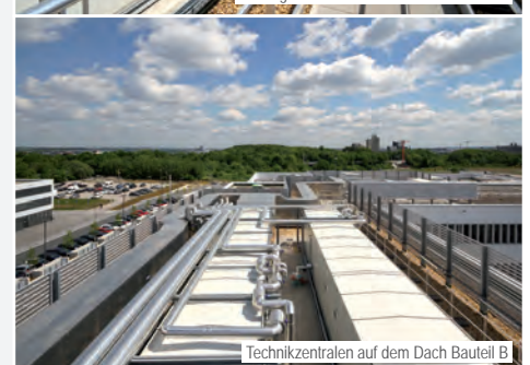
Lüftungszentralen auf dem Dach Bauteil B
