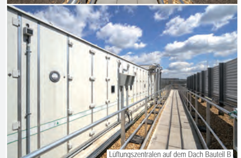
Lüftungszentralen auf dem Dach Bauteil B
