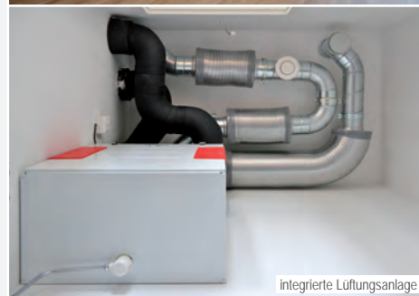
integrierte Lüftungsanlage
