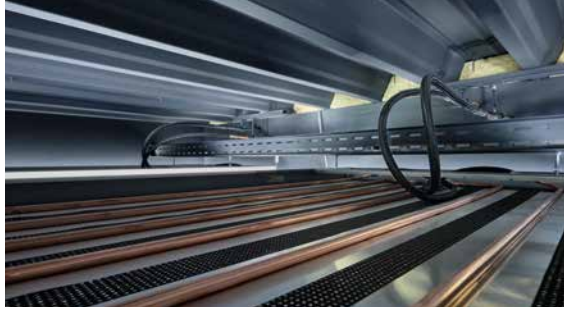
Heiz- und Kühldeckensegel wurden in den Büros der neuen Etage installiert. Sie bilden eine Komponente des LowExergie-Systems.
