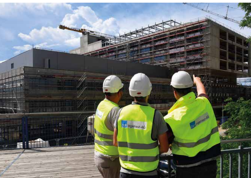
Baustelle, AFK Klinik am Eichert, Göppingen.
