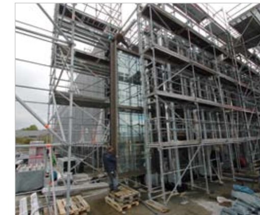
Das Element wird an Schienen an seinen Platz geschoben.
