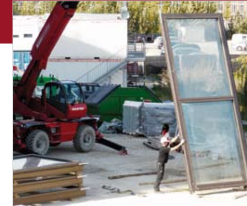
Mit einem mobilen Teleskopkran werden die Fassadenelemente angehoben.
